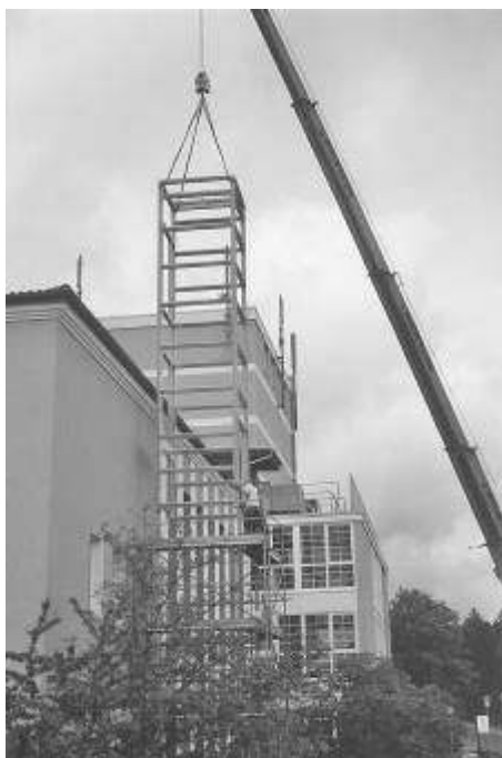
Montage des Fahrstuhls - Fotos: Althöhn
